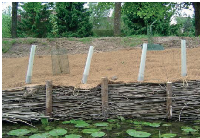
Ілюстрація 51: стабілізування берегової зони за допомогою плетених із деревини конструкцій (Франція)
